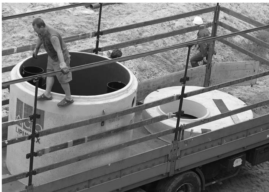
Разгрузка жиросепаратора LIPUMAX® NG 15 на ТРЦ "ОК"
