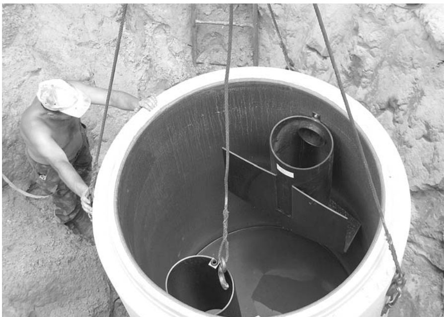
Монтаж жируловителя LIPUMAX® NG 7, ресторан "Мисливець", Гидропарк, г. Киев
